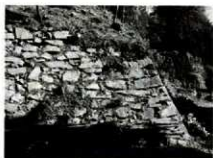
写真4 安土城(野面はぎ例)
