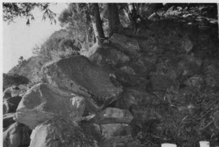
南曲輪隅角部
