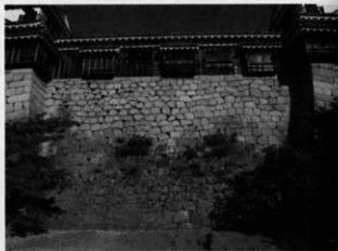
写真12 築石部（西より） ※右上部は⑥
