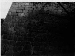
写真19 築石部 (南より)
