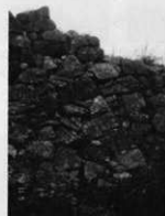
④天守台南西隅角部
