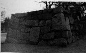
⑤原坂門石垣（北より）
