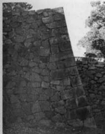
①東二之門橋台南東隅角部(南面)
