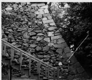
⑥ 南二の丸南西隅角部 (西面)
