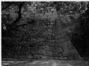
写真11 隅角部（北より）
