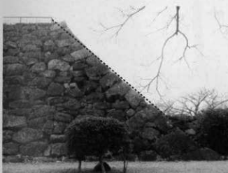
③天守台南東隅角部（南面）
