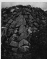
⑤本丸南門虎口隅角部
