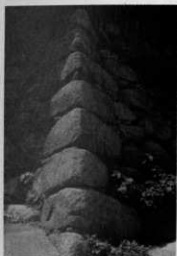
④鉄門石垣隅角部（北より）
