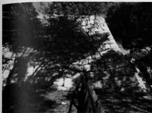
写真16 隅角部 (西より)
