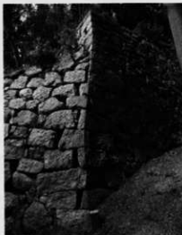
写真14 南登り石垣（③）鑄角 （南より）
