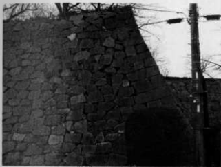
③二の丸松原櫓隅角部（北面）
