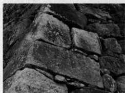
④ 同上③の拡大 (南東より)
