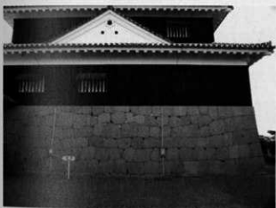
写真18 隅角部 (東より) ※天守台
