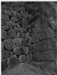
写真29 本壇天神櫓台石垣入角部（南東より）
