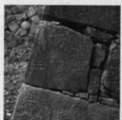
⑥隅角部の表面調整(南東隅角部)
