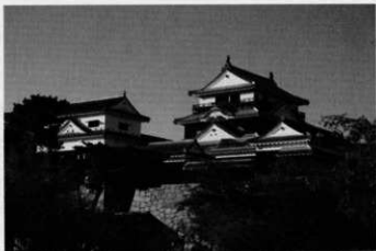
写真1 松山城本壇（南東より）
