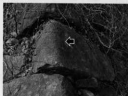
⑥小天守台石垣隅角部における角石稜線の調整
