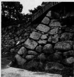
⑤鉄門隅角部（西より）
