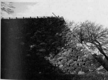
⑤小天守台石垣（南面）
