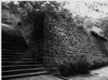
写真30 西山興隆寺石垣（南東より）
