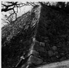
③ 武具櫓下南東隅角部 (南東より)
