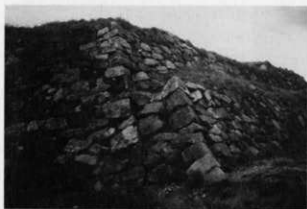
①天守台南西隅角部（西より）
