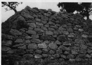
⑦本丸東面東南隅角部
