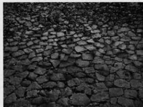
写真6 本丸周辺築石部（北より）
