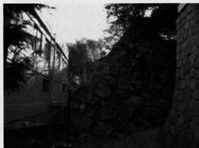
写真3 隅角部（北より）
