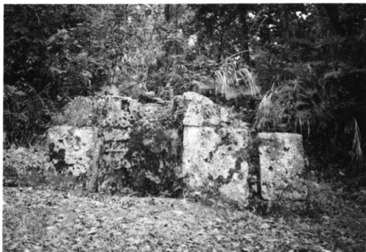
フェースカー（西側より）
