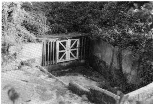
トーバルガー（北西側より）
