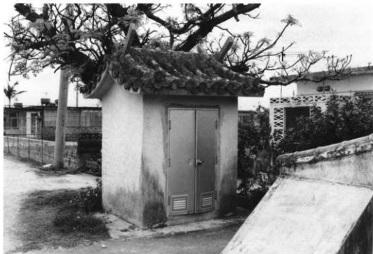
ティラ（北東側より）
