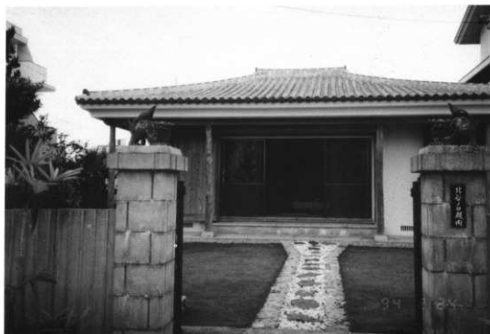
北谷ノロ殿内（南側より）
