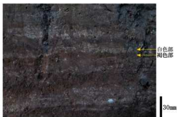
別編2写真3 秋田城築地塚の断面における 白色・褐色の互層
