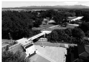
史跡公園連絡橋（南西から）
