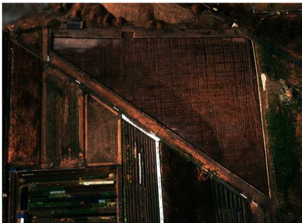
調査区全景 上層道橋完備状況（俯瞰。上が西）
