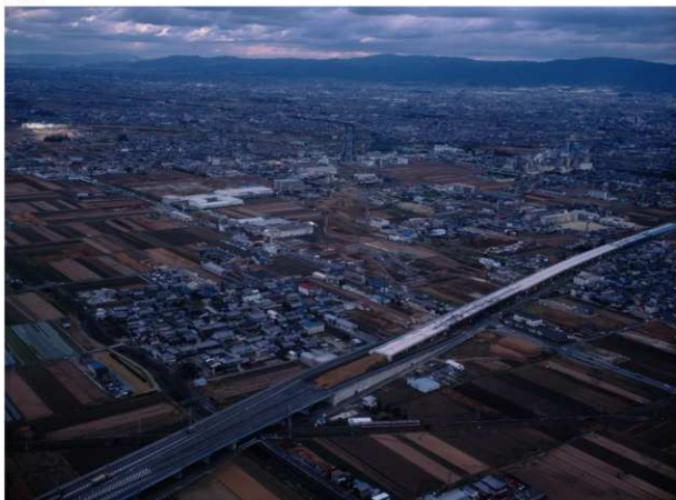
調査地遠景 航空写真(南西から)
