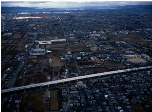
調査地遠景 航空写真(南南西から。手前が大和高田バイパス)
