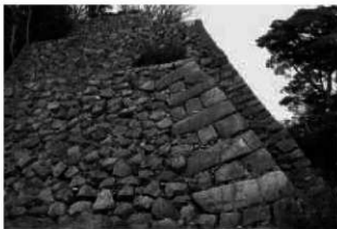
10 本丸南高石垣(辰巳櫓下)・隅角部
