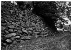
写真4 丑寅右方櫓台下の文禄期石垣 (破線は埋めこまれた部分)
