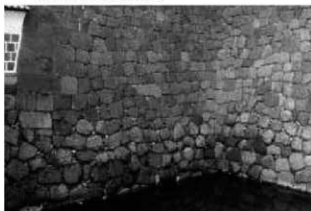
20 二ノ丸内堀石垣 上部は右が宝暦3年、左が文化5年修築
