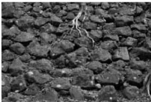
9 本丸南(申西櫓下)・築石部 自然面残すもの多く、刻印少ない。
