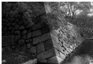
29 大坂城青屋口北西角石垣
