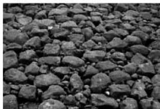
4 本丸東高石垣・築石部
