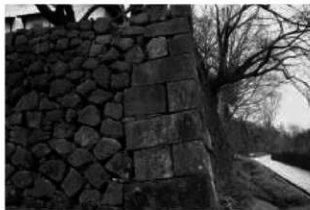
17 東ノ丸附段東面石垣 類石垣の石材等で寛文期に修築。
