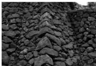
2 本丸丑寅櫓下東面石垣・隅角部
