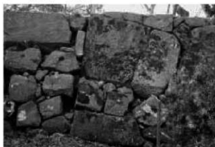
7 新丸尾坂門隅角部埋め殺し
