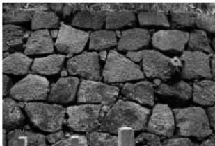
16 同左・築石部 類石材で寛文期に修築。
