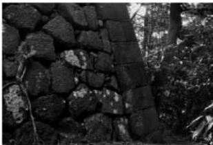
15 新ノ丸南石垣 類石垣の石材等で寛文期に修築。
