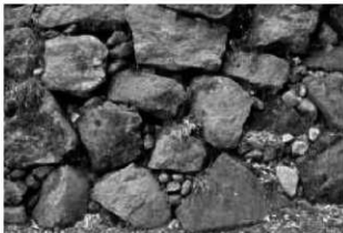
14 三ノ丸北石垣・築石部
