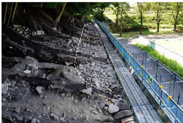
数寄屋屋敷西堀縁石垣（北から） 昭和53年修理時の掘削範囲を確認
