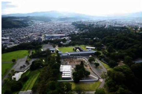
調査地点遠景(西から)
