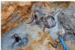
写真7 6区 SR6001 下層流路 木杭等出土状況 (南から)
