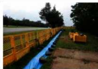
現場安全及び赤土流出対策状況
