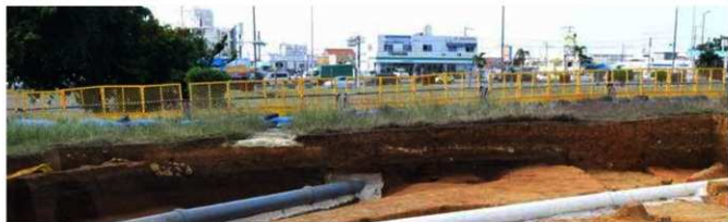
巻首図版 20 A地区⑦西壁、⑥南西壁
