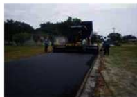
道路アスファルト復旧作業
