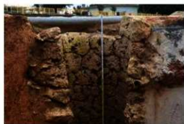
SE1 断り割り状況拡大（北から）
