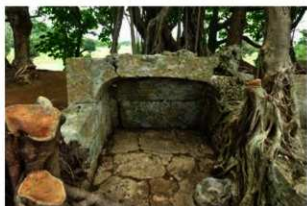
フール1 内部正面 (南から)
