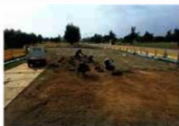
芝張り復旧作業
