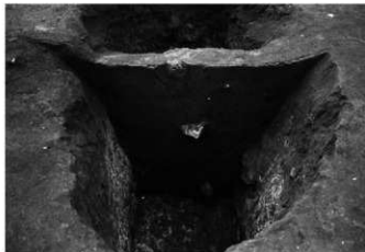
95-91号土坑セクション(南東より)
