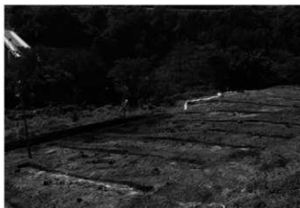
18区トレンチ全景(北東より)
