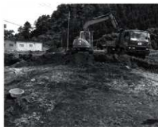
13. 表土掘削(北から)
