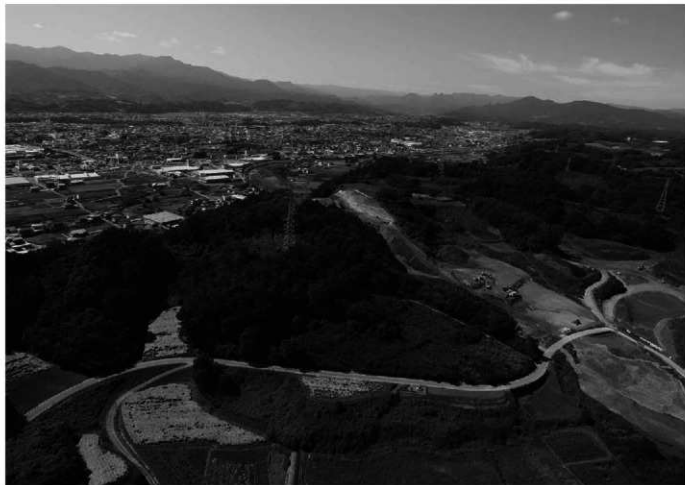
富岡城 城郭全景 北東から(富岡市街地・一ノ宮方面を望む)
