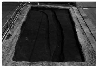
F区北 1・2面全景(1・2号溝) 南から
