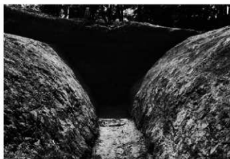
2号堀 土層断面 東から
