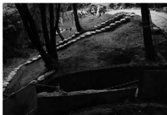
城郭北東部 2区 全景 南から
