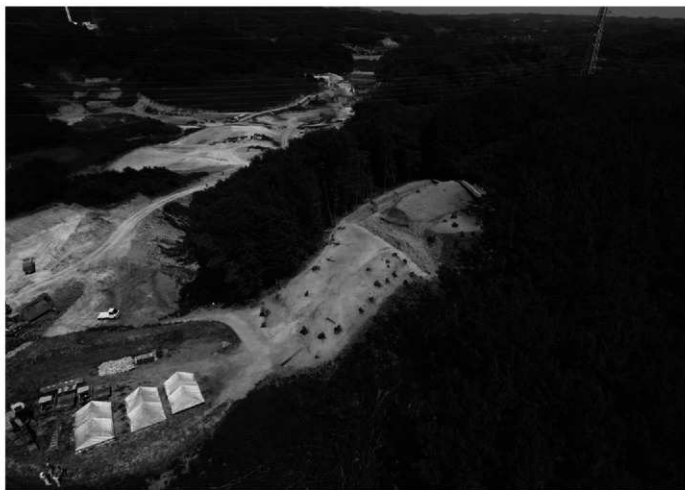
城郭西側(2・4郭) 全景 空中写真 南西から
