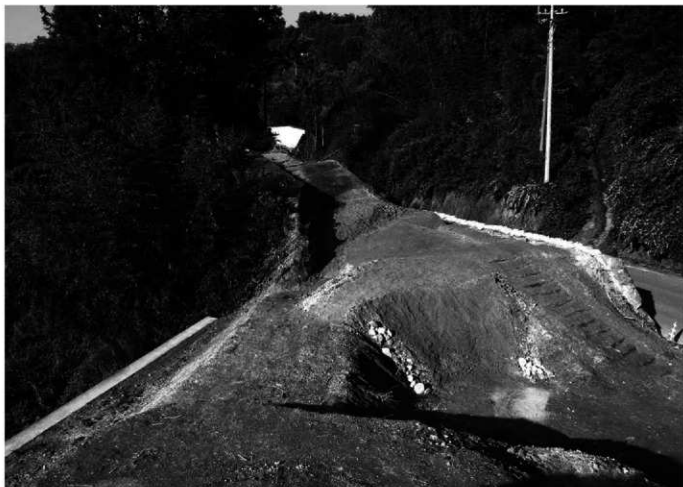
2 樋ノ下遺跡近景(東から)
