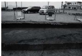
3区-2 地割れ状況 東壁土層断面付近
