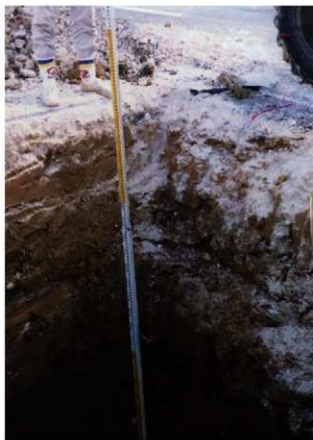
試掘 No. 3 上層
