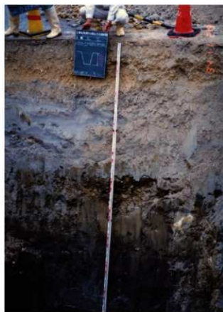
試掘 No. 3 上層
