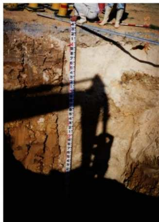
試掘 No. 5 上層
