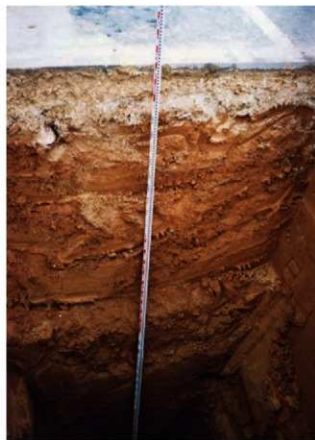
試掘 No. 7 上層
