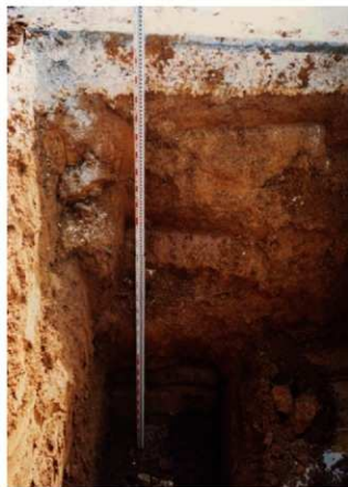
試掘 No. 2 上層
