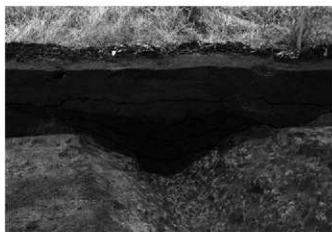
1区2号溝A-A'土層 北から
