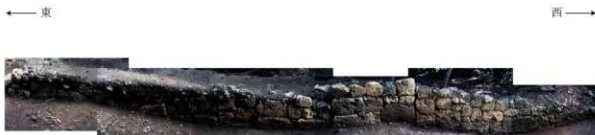
図版 39 四の曲輪南側城壁（南向きに撮影）
