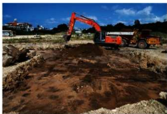
遺構面を保全しながらの汚染土壌撤去作業（北地区）
