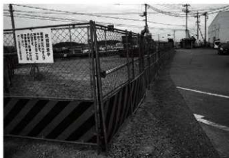
3 通行路に安全フェンスを設置
