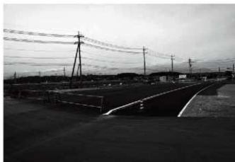
6 道路建設が進む調査地
