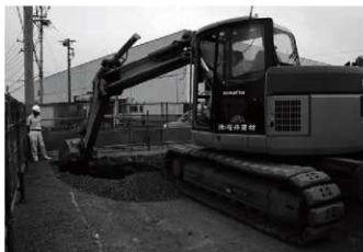
2 重機による表土の掘削
