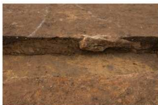
断面B：断面Aに類似した状況
