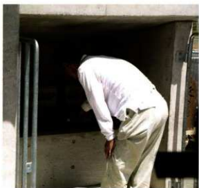
3. 新井戸での散水作業
