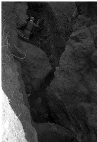
岩陰部での狭い中での作業状況 西から
