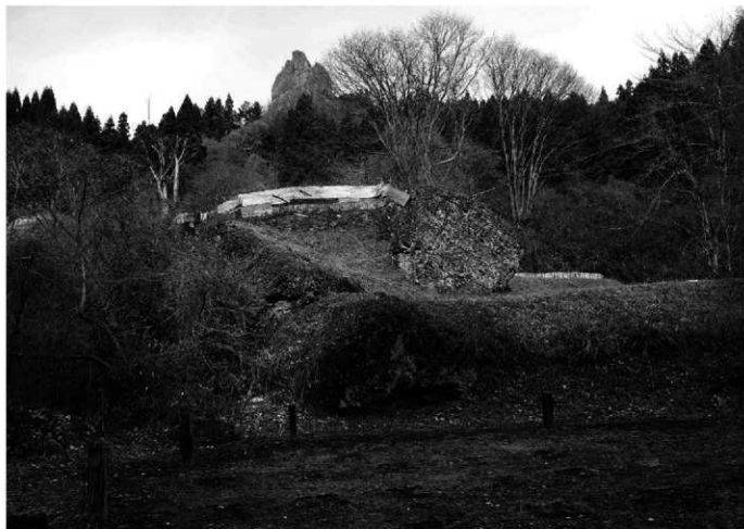
入山川沿いの転石と高岩(大笠山) 南東から(平成23年12月6日撮影)
