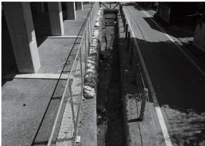
浜町古墳群 1区全景(西から)
