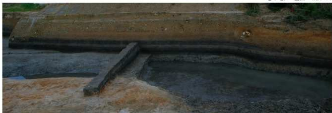
HB④ロ地区 壁面Ⅳ、ベルトⅣ(南西より)
