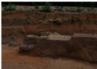
HB①地区 中央ベルト K12 (南西より)
