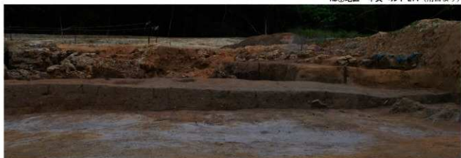
HB①地区 中央ベルト K19-20 (南西より)
