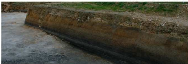
HB④イ地区 壁面Ⅲ(南より)
