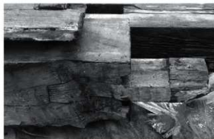
写真1 土台継手部分。雇い鎌納を使った継手。正面は底面で、礎石の面にひかり付けのための欠き込みがある。写真上面は土間内部側となり、大戸等の建具の敷居の役割をする付け榑端が見える。また、胴付きミゾがあることから、この材は女木である。
