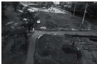
写真10 11号建物俯瞰。11号建物は中央に道を挟み、南北に位置している。左は5号道、右は10号建物、中央上部は6号道を挟み1号建物に接している。
