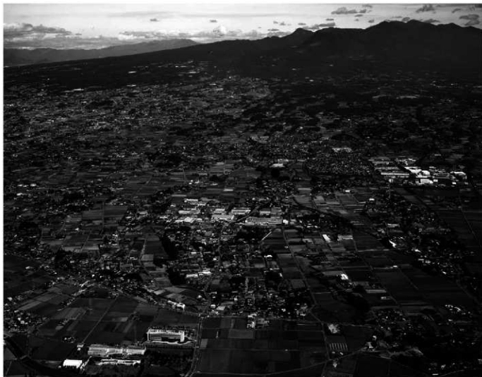
前橋市下沖町上空からみた赤城山南麓 平成13年撮影 ●が遺跡の位置、右が芳賀東部住宅団地、工業団地である。 南に芳賀西部工業団地がある。手前が広瀬川低地帯、左隅に見えるのが桃ノ木川である。
