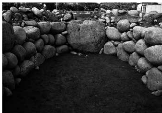
2 1号古墳石室床石除去後奥壁（南から）
