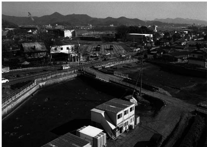
2 南調査区（1区）第5面全景（南西から）
