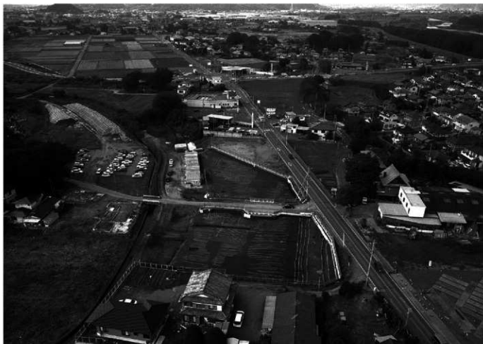
2 南調査区全景（第3面調査中、東から）
