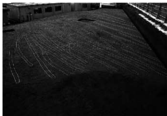
2 1-2区第3面直上島(北東から)
