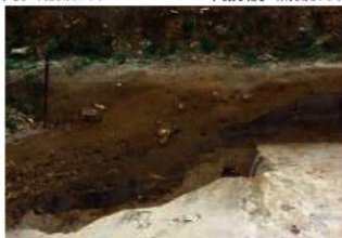
南壁部西側護岸裏土層断面（西側より）
