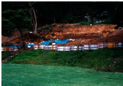
no.3・4トレンチ(C・D-3・4) 遠景
