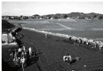
3-1区 4面作業風景 (南東から)
