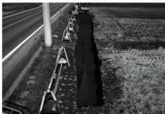
8. IX区3号復旧溝全景(南から)
