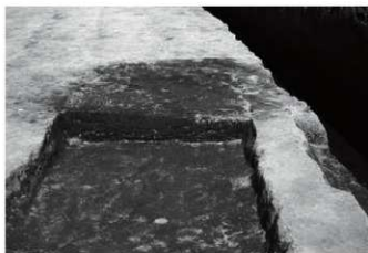
3. I区4号復旧溝土層断面(東から)
