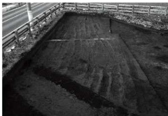
6. IX区1号復旧溝全景(南から)
