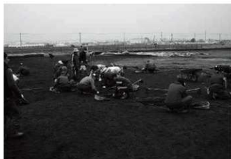
5. VI区古代～古墳時代遺構面調査風景(南西から)
