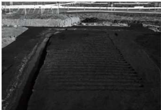
2. V区1号復旧溝群全景(西から)
