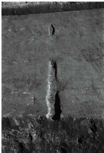
3. V区33号溝全景(西から)
