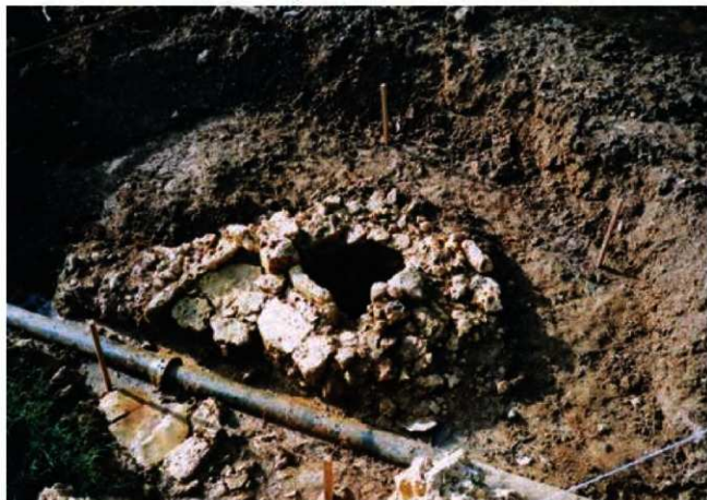
No. 2 トレンチ チンガー完掘状況
