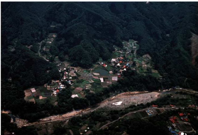
2 発掘以前の遺跡地遠景（北東上空から） 左手の集落の中を流下するのが東沢。その右手が横壁中村遺跡。平成6年撮影。
