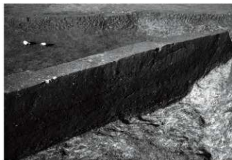
5 A区9号、10号竪穴住居土層断面A-A' (北東端・南東から)
