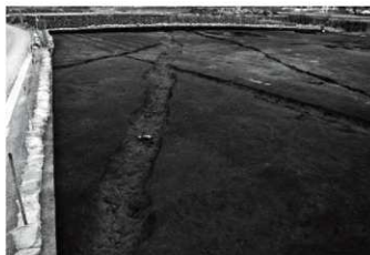
4 D区3号溝全景(南西)
