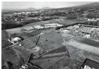
2号堀を含む市道西全景 南
