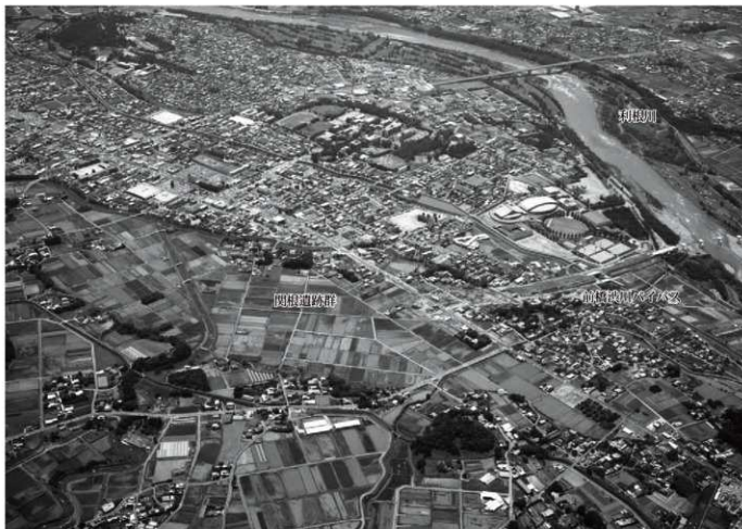
上武道路 路線(6) 関根地区～国道17号地区
