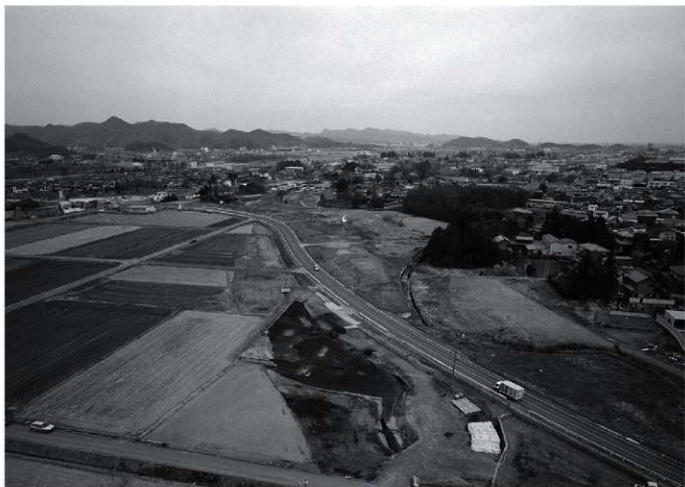
道跡遠景 (西から)
