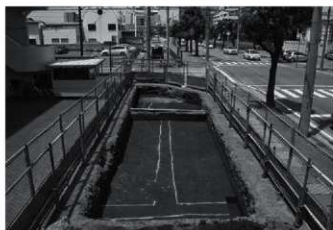
26区2面 (As-B下面) 全景 (東から)
