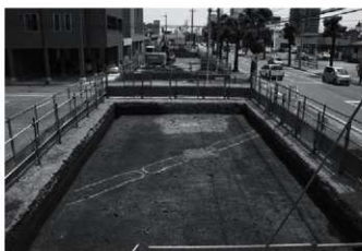
5区2面 (As-B下面) 全景 (西から)
