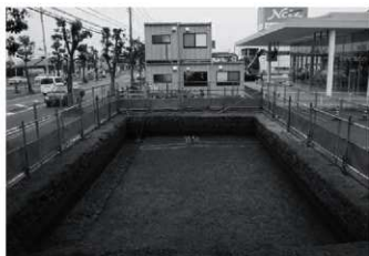
41区2面 (As-B下面) 全景 (西から)
