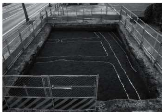
11区2面 (As-B下面) 全景 (東から)
