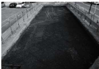
10区2面 (As-B下面) 全景 (西から)
