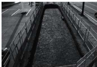
33区2面 (As-B下面) 全景 (東から)
