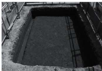
31区2面 (As-B下面) 全景 (西から)
