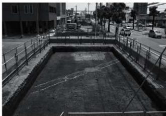
写真1 ①平坦で風化が進んだ水田面(5区)
