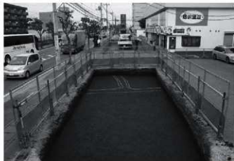
35区2面 (As-B下面) 東半 全景 (西から)
