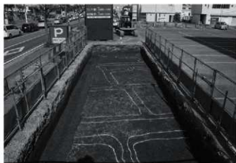
38区2面 (As-B下面) 全景 (西から)
