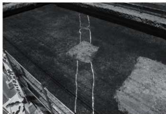
5区2面 (As-B下面) 桩 (南東から)
