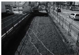
37区2面 (As-B下面) 全景 (東から)
