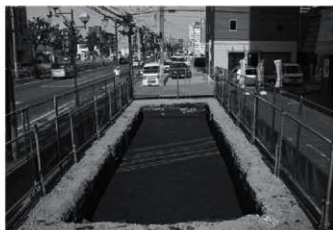
28区 2面 (As-B下面) 全景 (西から)
