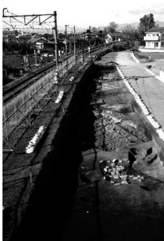
B区1面全景（東から）
