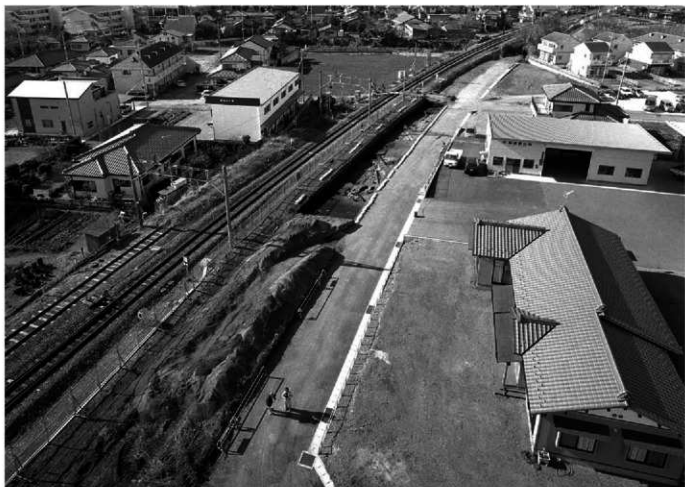
喜多町道跡全景（東から前橋方面を望む）
