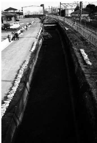
B区2面全景（西から）
