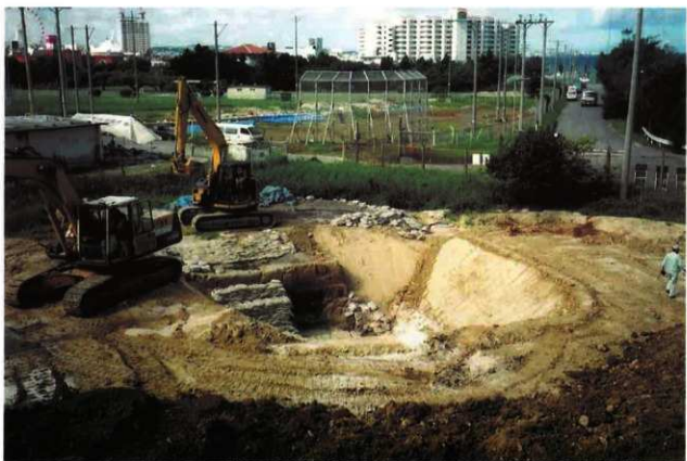
図版31：埋め戻しの状況
