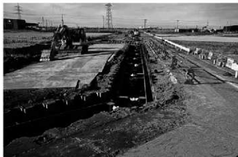
調査前風景 (南東から)
