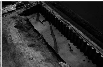
SD508(右)・507(中)・512(左) 全景(北西から)
