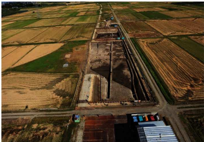
上層・中層 完掘全景(西から)
