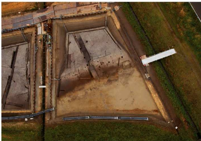
東側調査区上層 完掘全景(真上から:上が北)
