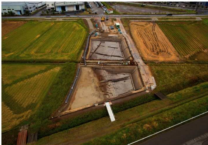
上層 完掘全景(東から)
