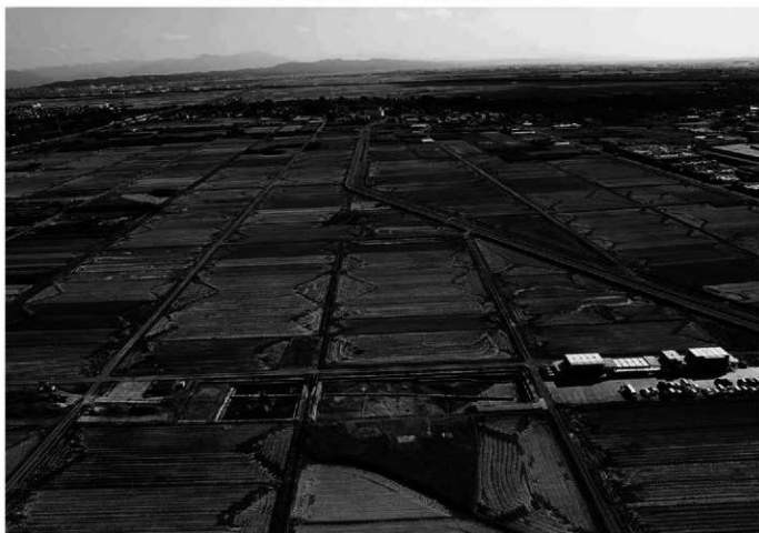
上層・中層 完掘及び新津方面を望む(北から)
