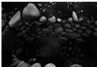
4 1号墳玄室部右側壁（北西から）
