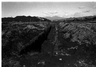
2 Aトレンチ調査状況(南東から)
