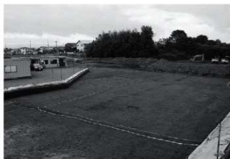
12区第2面全景（南西から）
