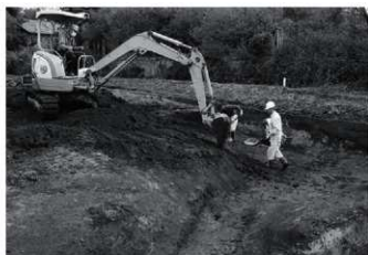
小型掘削重機による「上池」2号溝埋没土の除去 (南西から)
