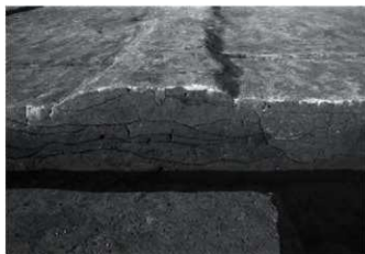
② 2 a区34号溝陥畦状遺構断面（南から）
