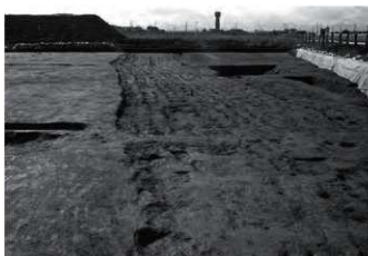
② 4号復旧溝全景（東から）
