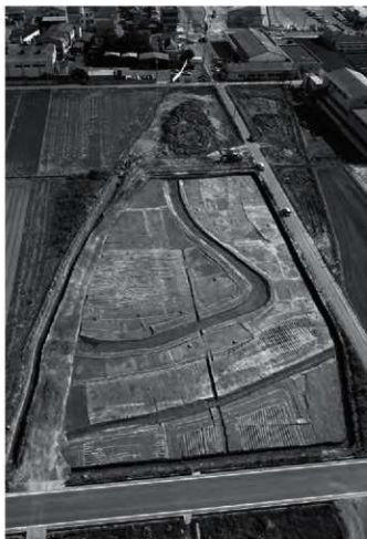
① 1a区 1面全景 (西から)
