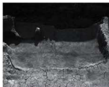
① 1号土坑（北から）
