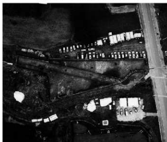
十二廻り遺跡Ⅰ区北側全景 上から
