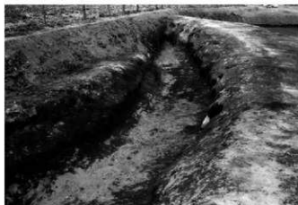
Ⅱ区1号溝全景 南から
