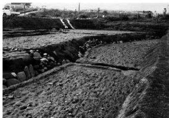
Ⅲ区2～4号溝段差石垣遠景 南東から
