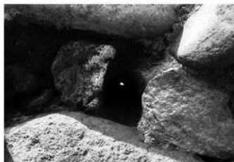
Ⅱ区7号水田取水口-1 東から
