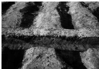
IV区2号畑土層断面 南東から
