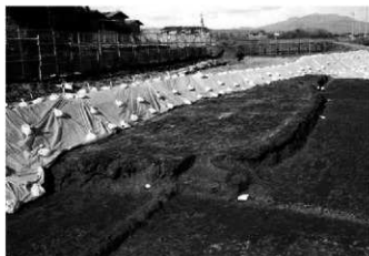
V区23～25号水田全景 南東から
