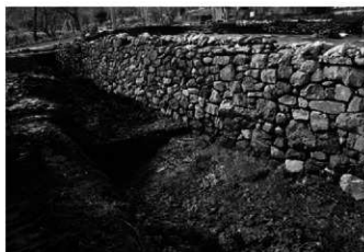
4 4号石垣段下の様子 北東→
