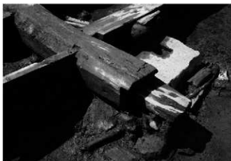
2 1号建物3号床東側大引 (No.94)・根太接合の様子 南東→
