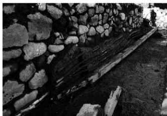
4 10号建物西側土壁全景（柱・竹小舞取り上げ後） 南東→
