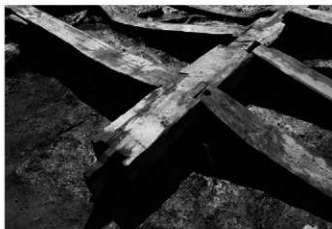
3 1号建物3号床東側大引 (No.86)・根太接合の様子 北東→
