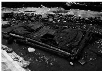
1 4号建物全景② 南東→
