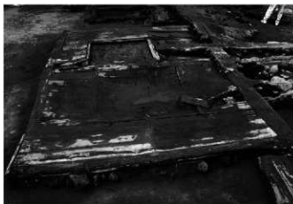
6 1号建物3号床全景① 南→
