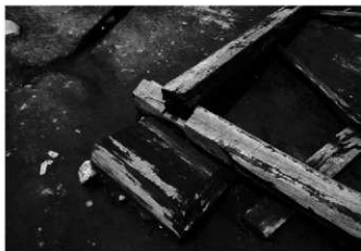
4 4号建物南西隅土台仕口の様子 南東→
