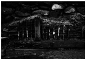
3 10号建物西側土壁① 東→
