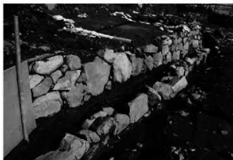
3 2号石垣全景 西→
