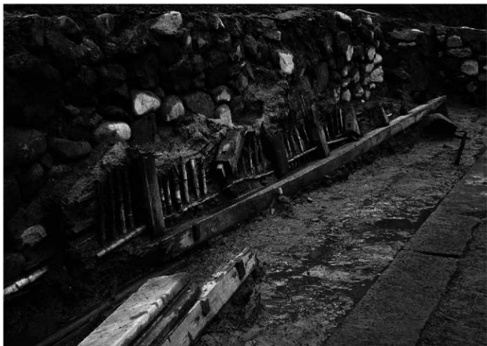
1 10号建物西側土壁全景① 南東→
