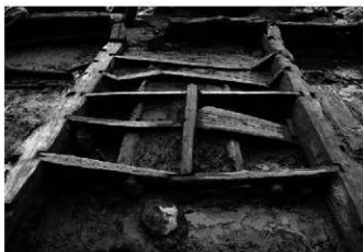
8 5号建物2号床下の様子 南→
