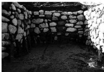
4 5号屋敷跡1号施設壁沿いの杭列全景 東→
