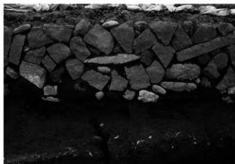
2 1号石垣と下面に堆積した天明泥流の様子 東→
