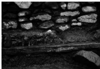
2 10号建物西側土壁④ 東→
