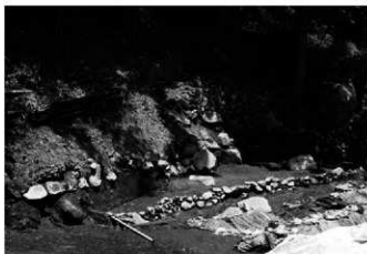
4 6・7号石垣全景 南西→
