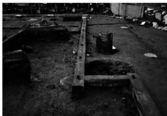
3 1号建物北側土台（No.12・13）全景① 東→
