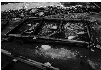
4 4号建物全景(土台・大引面) 南→
