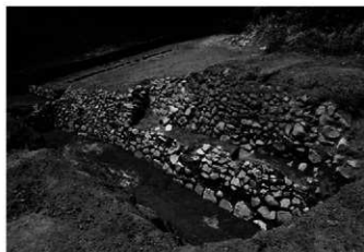
4 8号石垣全景② 東→
