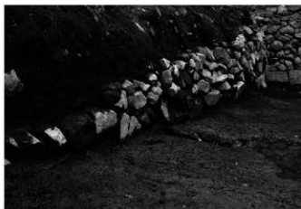
1 16号石垣全景 北東→
