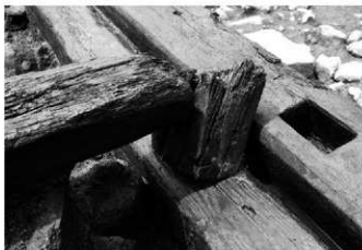
3 4号建物北側土台・柱・大引接合の様子② 東→
