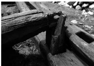
2 4号建物北側土台・柱・大引接合の様子① 東→
