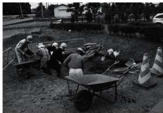
4区人力による掘削（南東から）
