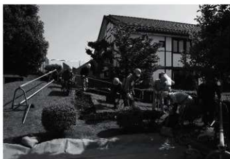
3区人力による掘削（北から）
